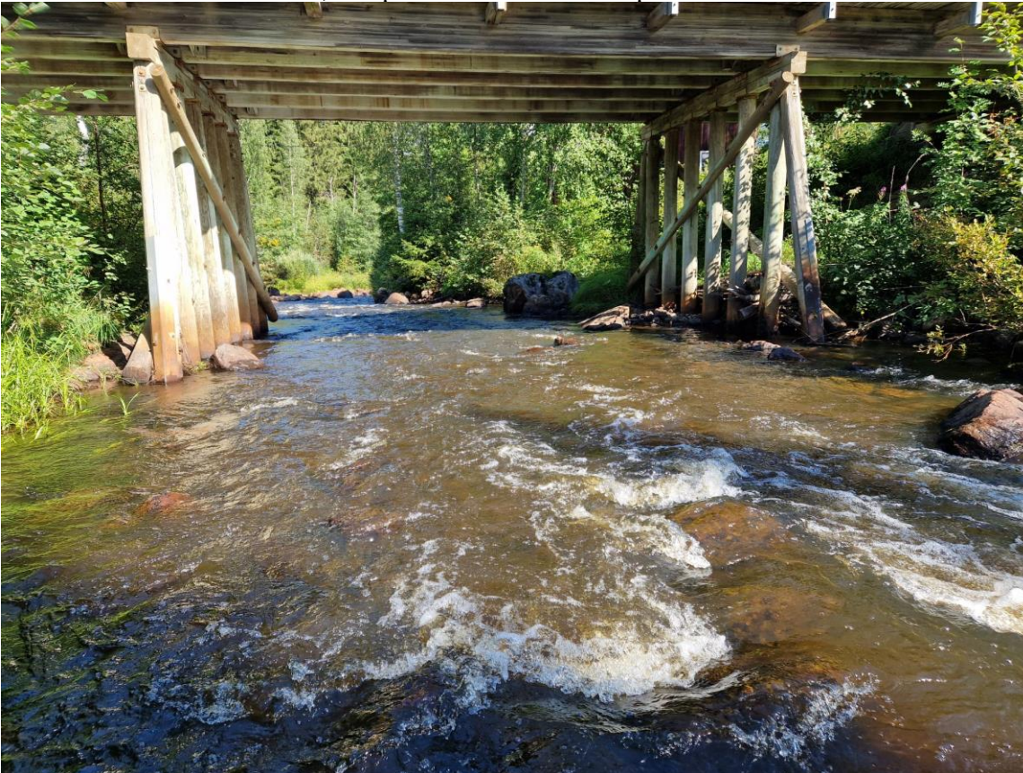
Kuva 6. Ala-Kosken yläosa, Haapovaarantien sillan länsipuolella
