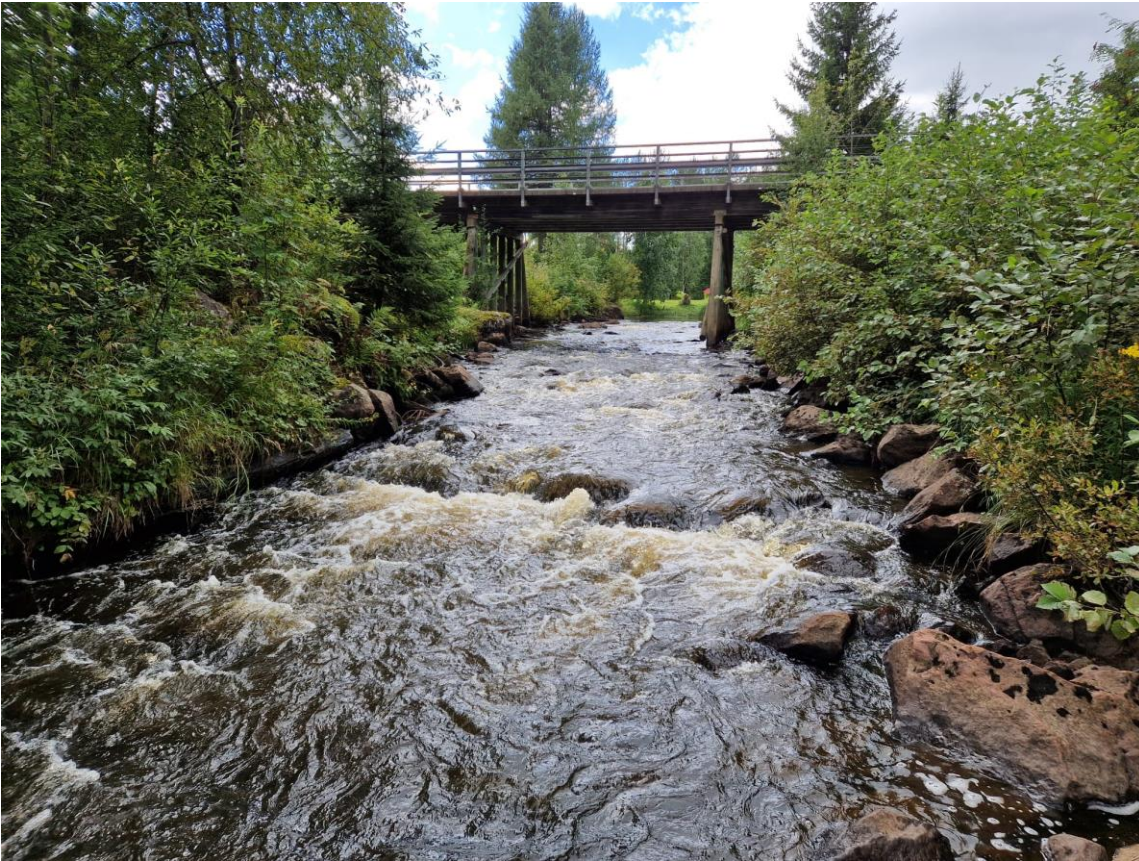
Kuva 6. Ala-Kosken alaosa, Haapovaarantien sillan itäpuolella.
