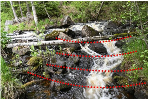
Kuva 27. Kuvassa näkyvä nousueste muokataan kalankulkuväyläksi purkamalla uoman nykyinen kivikko ja kasaamalla tilalle useita matalia pohjapatoja. Tavoitteena olisi, että tässä kalaväylän kaltevuus olisi noin viisi astetta.
