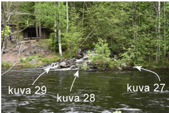
Kuva 26. Kuvassa näkyy Kemppaanjoen luusua. Tämän keskelle on muodostunut pieni saareke, jonka molemmin puolin virtaus ohjautuu. Kuvaan on merkitty, miltä kohdin kalojen kulkua häiritsevistä kivistä kukin lähikuvista 27–29 on otettu.
