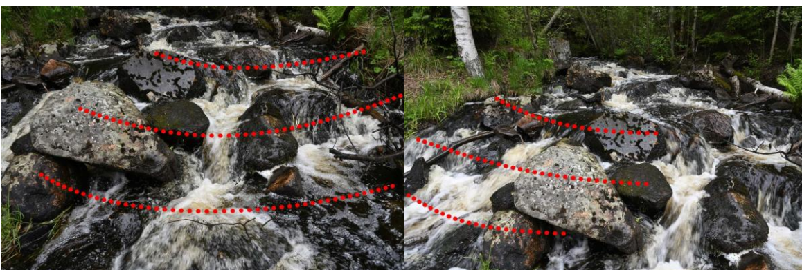
Kuvat 28 ja 29. Kuvissa näkyy luusuan lännenpuoleinen kynnyskivikko. Tätä avataan ja jatketaan alavirran suuntaan niin, että kivistä muokattavien pohjapatojen välinen korkeusero vähenee selvästi. Kaltevuus voi tällä osalla kuitenkin jäädä suuremmaksi kuin kuvassa 27 esitetyssä sivu-uomassa.
