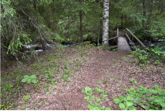
Kuva 32. Ruskeakoskentieltä alkava polku johtaa Kemppaanjoen kävelysillalle, jonka eteläpuoleiselta reunalta kaivinkone on tarkoitus ajaa uomaan.
